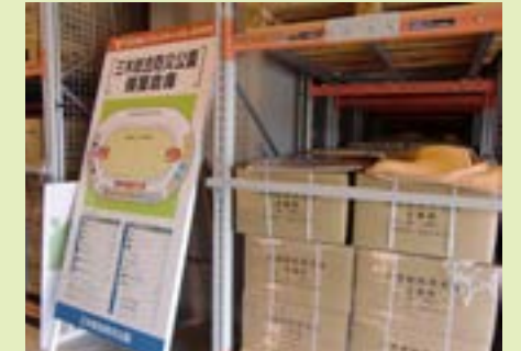
陸上競技場のバックスタンドが災害備蓄倉庫となっている三木総合防災公園。
